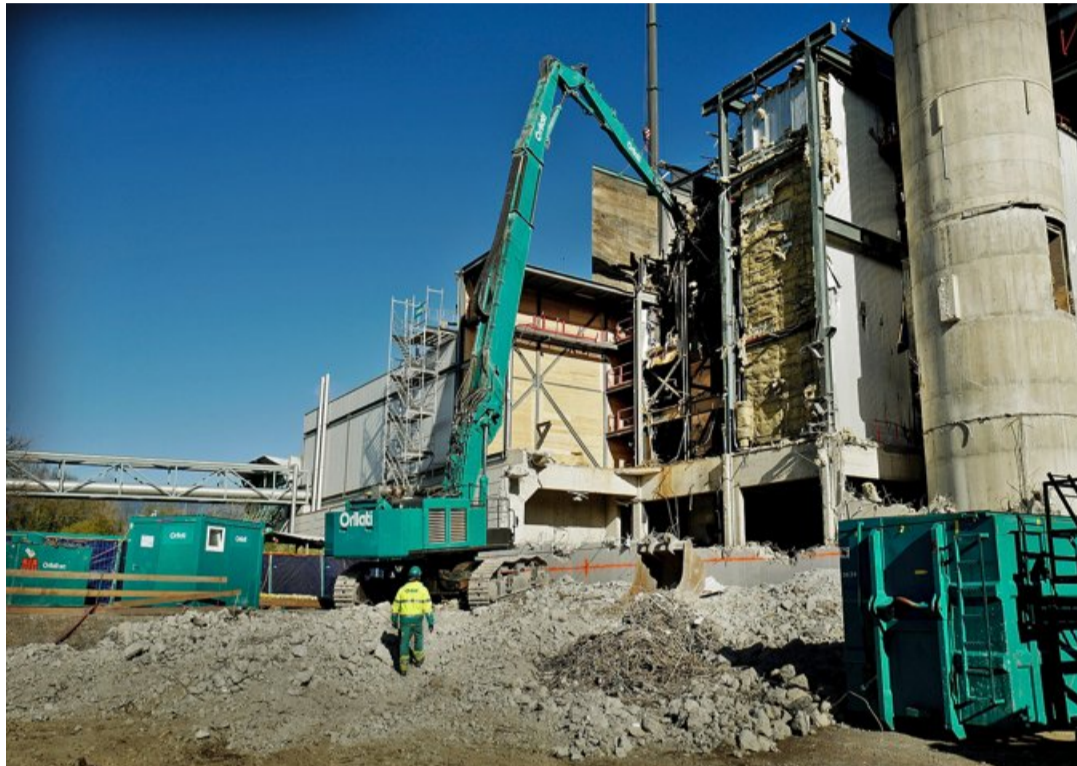
La face du bâtiment sud a disparu. Reste, sur la droite, la cheminée historique construite en 1978. Sa démolition à venir nécessitera l'engagement d'un robot télécommandé. LAURENT GUIRAUD
